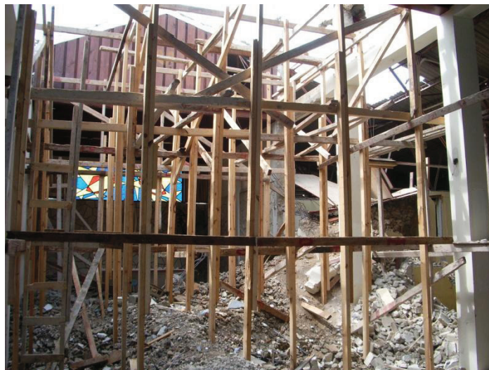
DÉMOLITION ET DÉBUT DE LA RECONSTRUCTION DE LA CHAPELLE DU FOYER
